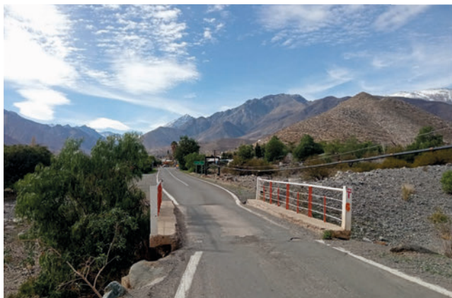
Figura 3. Fotografía del puente del poblado El Pedregal, se observan algarrobos en las inmediaciones de los arroyos.
