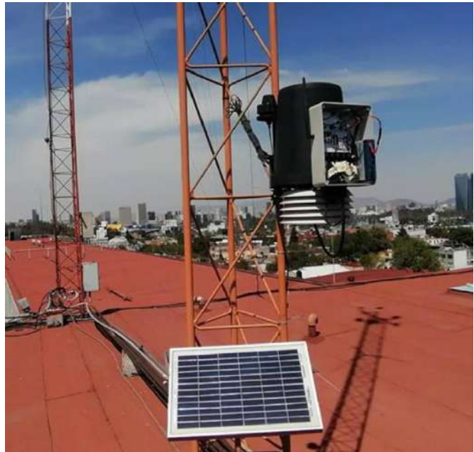
Figura 3. Sensores de una estación del PEMBU.
