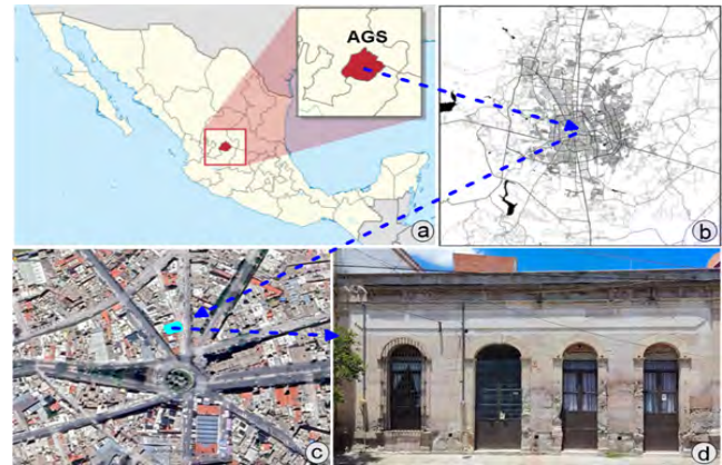
Figura 1. Localización de la Casa Rosal 102a, Barrio de La Purísima, estado de Aguascalientes, México. a) Mapa con la división política de la República Mexicana en donde se resalta en el recuadro el estado de Aguascalientes (AGS). b) Mapa de la traza urbana de la ciudad de Aguascalientes. c) Fotografía aérea del barrio de La Purísima, Aguascalientes; en azul se destaca la ubicación del inmueble de interés. Coordenadas geográficas (13Q 780625 m E; 2422363 m N). d) Imagen de la fachada Casa el Rosal 102a, diseñada por el arquitecto Refugio Reyes Rivas (1862- 1943).
