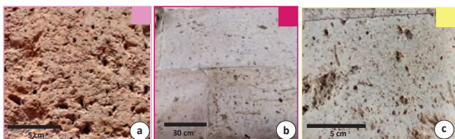
Figura 5. Fotografías de detalle de las texturas de las tres ignimbritas que componen la fachada La Casa Rosal 102a; a) ignimbrita amarilla a pardo, b) ignimbrita rosa claro-naranja y c) ignimbrita color rojizo-rosa.
